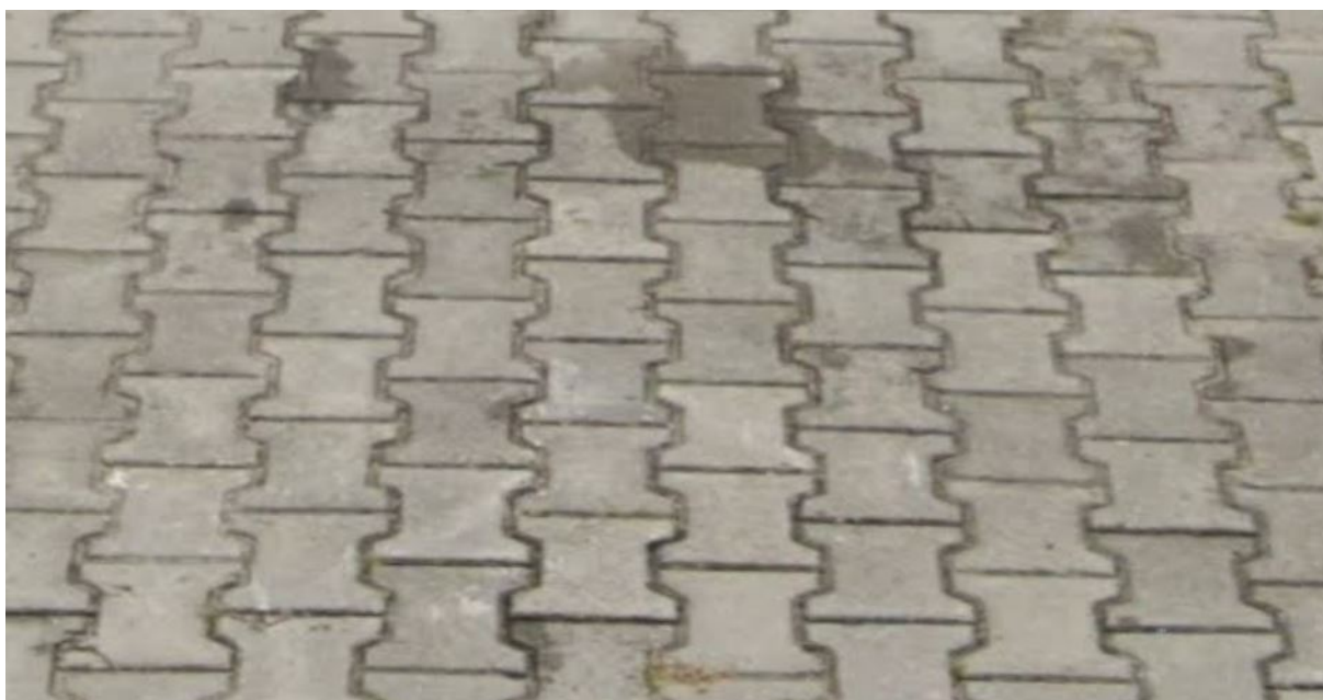
Zdj. nr 12 Kostka brukowa kolor szary (nawierzchnia zjazdów oraz miejsc postojowych)
