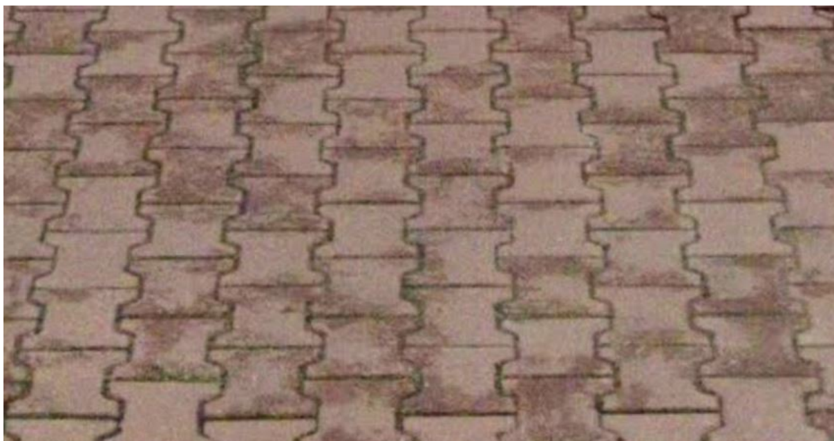
Zdj. nr 11 Kostka brukowa kolor czerwony (nawierzchnia ciągów pieszych)
