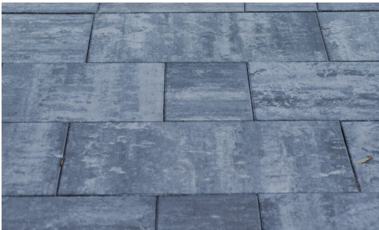
Zdj. nr 18 Kostka wielkoformatowa kolor freddo – ciągi pieszce (analogia do wykonanej centralnej części Rynku)
