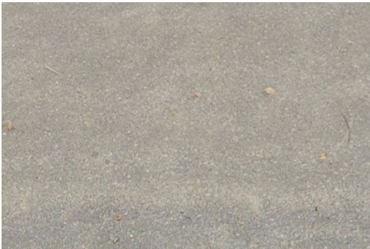
Zdj. nr 17 Nawierzchnia z mieszanki mineralno-asfaltowej - kolor szary (nawierzchnia miejsc postojowych)
