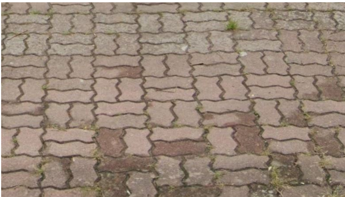
Zdj. nr 16 Kostka brukowa kolor rubin (nawierzchnia ciągów pieszych)
