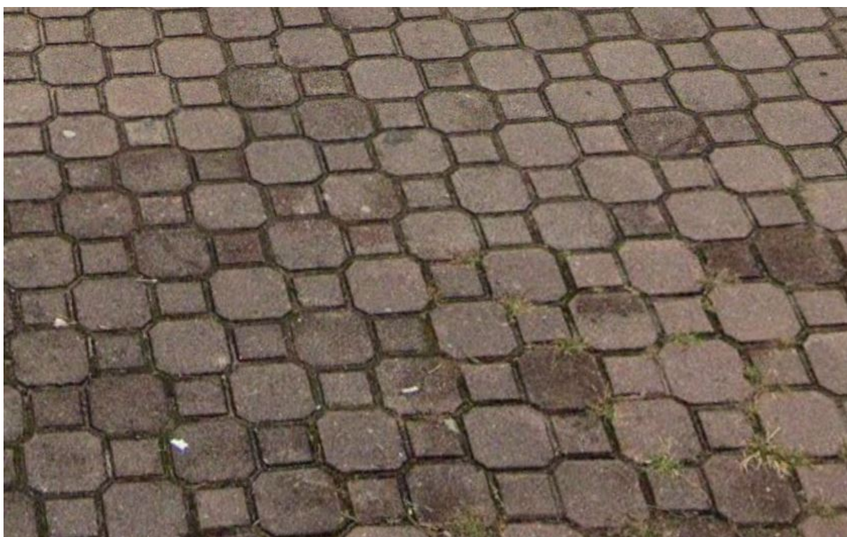
Zdj. nr 14 Kostka brukowa kolor rubin (nawierzchnia ciągów pieszych)
